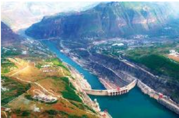
图 20: 溪洛渡水电站
