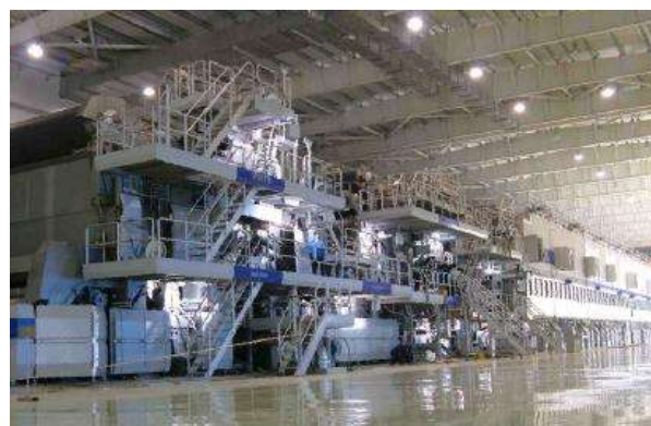
图 22：新闻造纸车间建设安装工程
