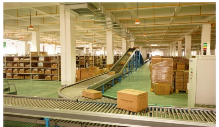
图表 35 全棉时代黄冈物流中心自动化立体仓库
