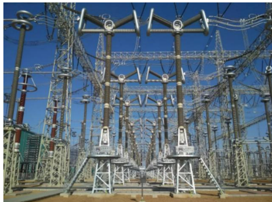
图46: 公司研制的世界上首台 1100kV 滤波器组断路器
