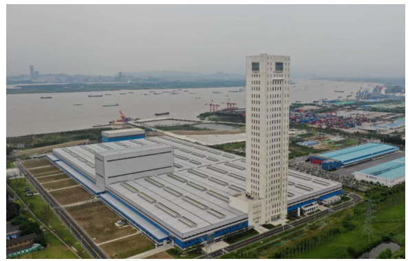
图4：公司交联电缆生产专用立塔
