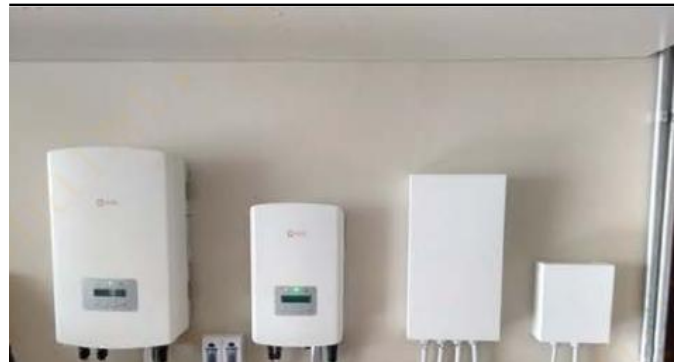
图表 25. 组串式逆变器示意图
