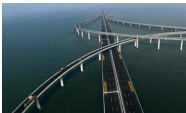
图表2：世界第一跨海大桥山东高速胶州湾跨海大桥
